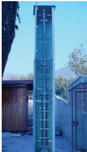
esempi di camuffamento con finto comignolo per zone prevalentemente residenziali e urbanizzate
