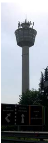
esempi di installazione in coabitazione delle antenne per stazione radio base con altre strutture o servizi esistenti (torre acquedotto, torre direzionale, traliccio elettrodotto)
