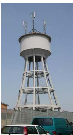
esempi di installazione in coabitazione delle antenne per stazione radio base con altre strutture o servizi esistenti (torre acquedotto, torre direzionale, traliccio elettrodotto)
