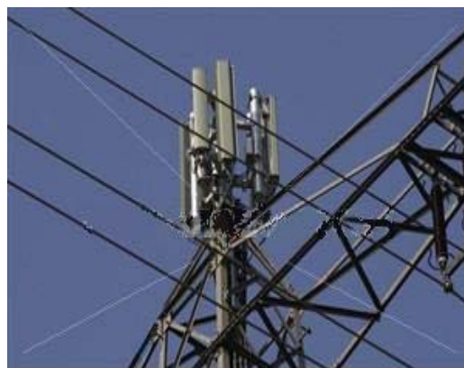
esempi di installazione in coabitazione delle antenne per stazione radio base con altre strutture o servizi esistenti (torre acquedotto, torre direzionale, traliccio elettrodotto)
