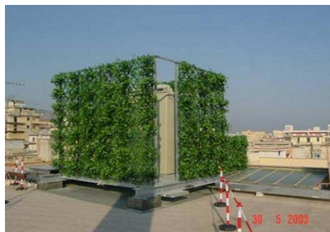
esempi di mitigazione degli impianti alla base del palo mediante l'impiego di materiali di basso impatto ed in sintonia con il carattere della zona (es . shelter impianti realizzato in legno e di piccole dimensioni - recinzioni apparati con camuffamento di reti a verde sintetico e/o di essenze verdi naturali quali rampicanti o altro).
