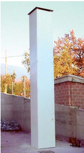
esempi di camuffamento con finto comignolo per zone prevalentemente residenziali e urbanizzate
