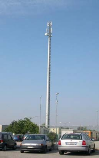
esempio di struttura di dimensioni ridotte con profilo lineare e affusolato
