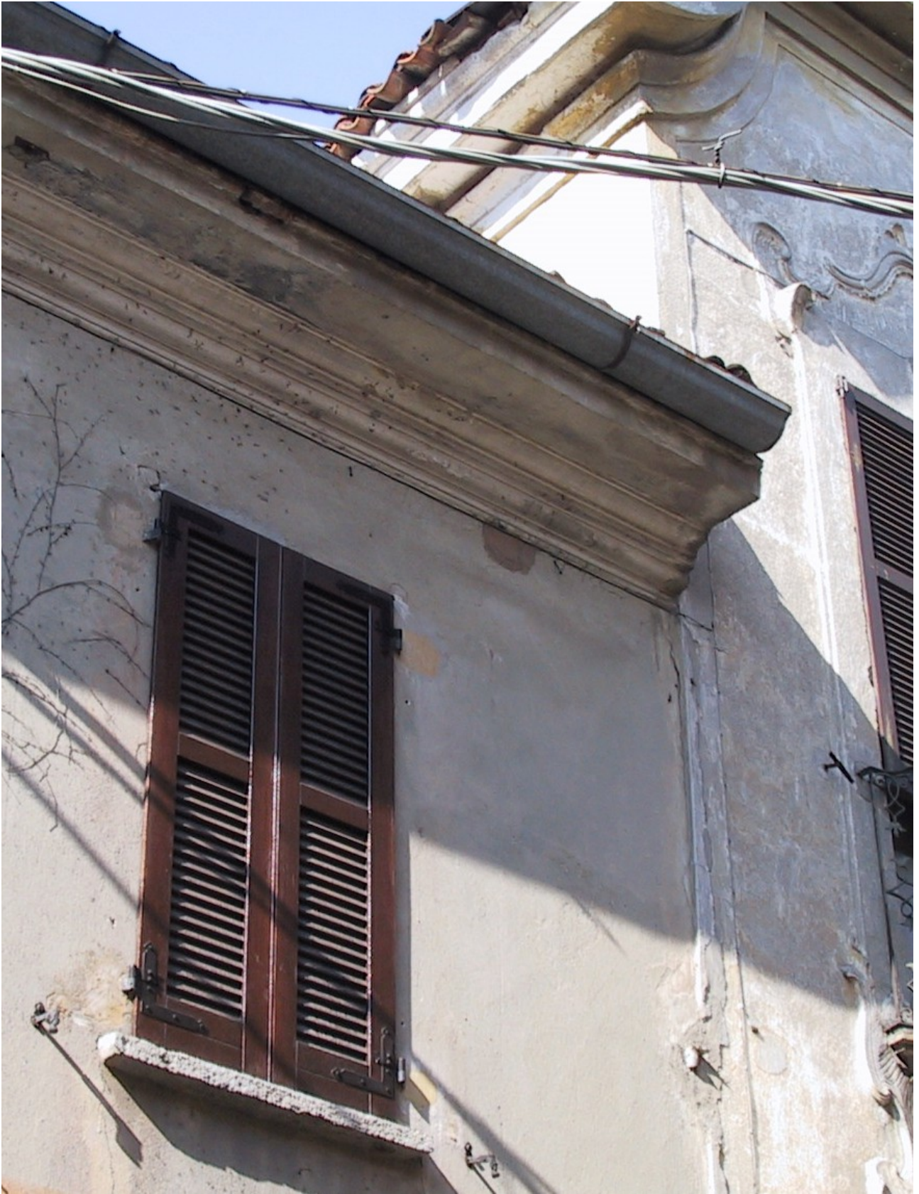
Cornice di gronda sagomata in cemento.
